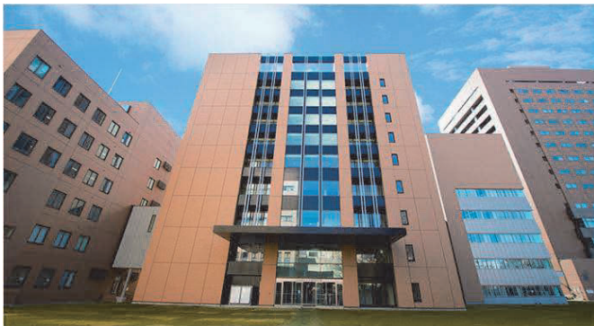
西17丁目通り (西側) から見た写真
